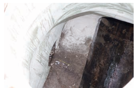
Die neue Schachtauskleidung passt sich der Schachtgeometrie bis zur Berme perfekt an.
