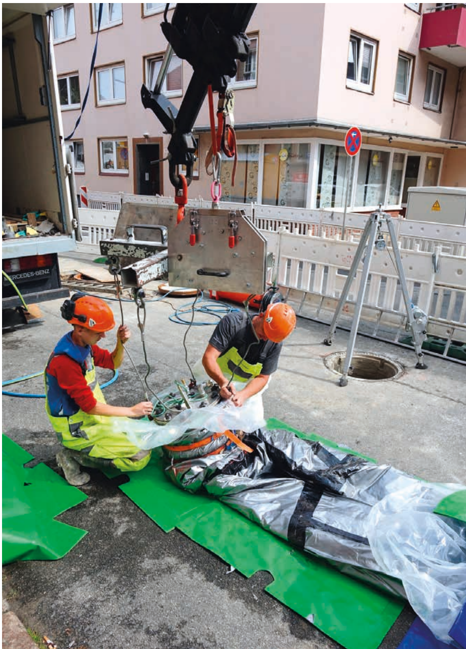
Vorbereitung des Vertiliners für den Einbau
