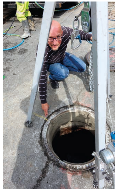
Vertiliner-Inhaber Peter Eschenbrenner zeigt auf die Markierung, die benötigt wird, um den Vertiliner in der richtigen Position in den Schacht einzubauen.
