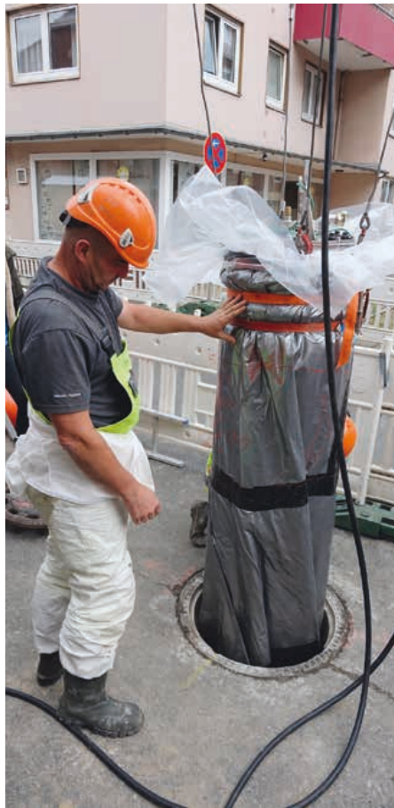
Einhängen der Schachtauskleidung
