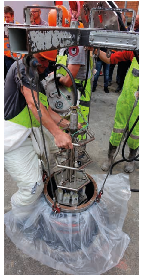
Für die Aushärtung wird eine Lichtquelle eingeführt und die Schachtauskleidung mit Druckluft beaufschlagt.
