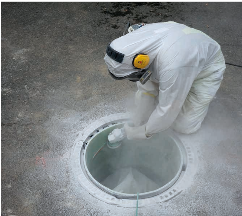
Nach der Aushärtung wird der Vertiliner unterhalb der Schachtabdeckung abgefräst. | Fotos: Diring & Scheidel Rohr-sanierung
