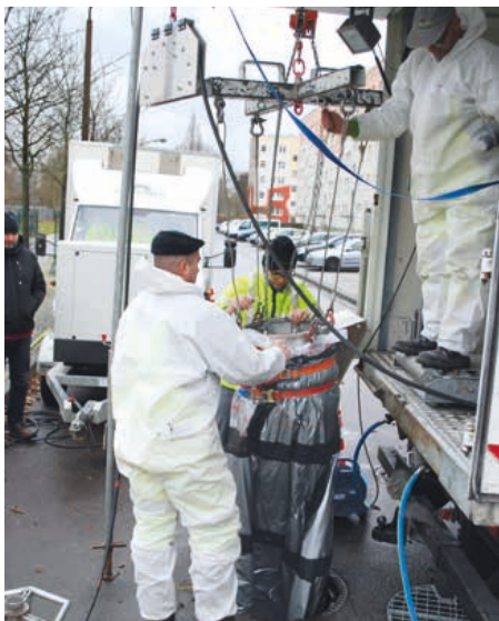
Einbau eines Vertiliners in Stendal.
