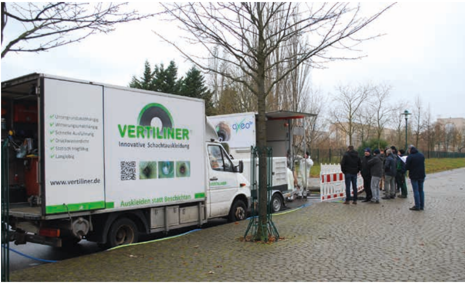
In Stendal kam noch Einbau- und Aushärtetechnik der Firma Vertiliner zum Einsatz. Demnächst wird Frisch & Faust in eigene Ausrüstung investieren.
