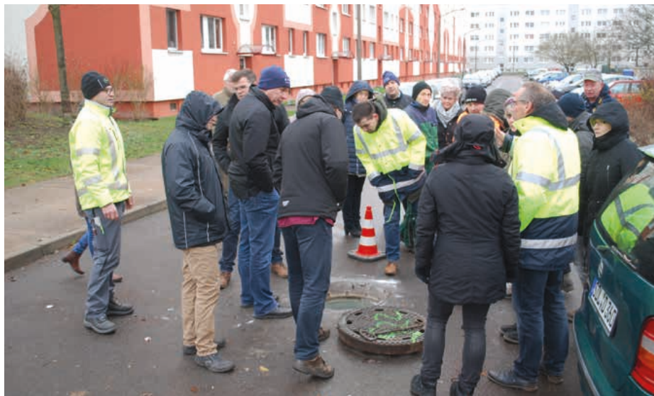
Das Schachtsanierungsverfahren stieß auch bei Kanalnetzbetreibern aus dem Umland auf großes Interesse.
