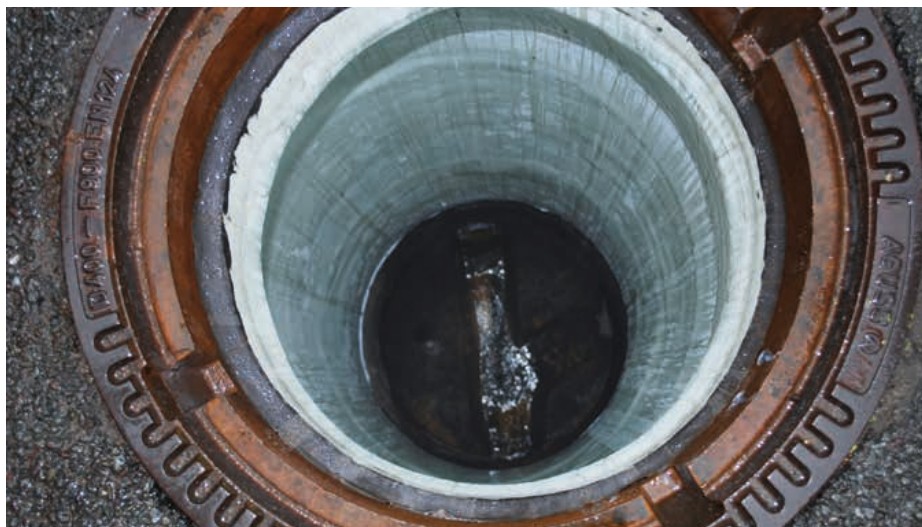
Blick in einen sanierten Schacht. Die Auskleidung des Gerinnes und die Anbindung der Zuläufe erfolgt nachträglich per Hand mit GFK-Laminat.
